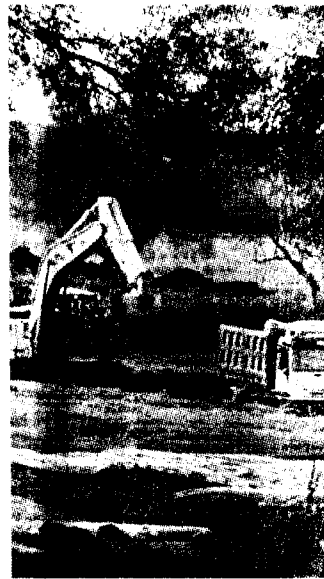
Il cantiere del nuovo ospedale
