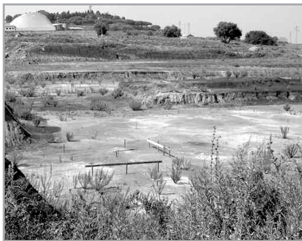
TUTTO IMMOBILE Il cantiere per la costruzione dell'ospedale
