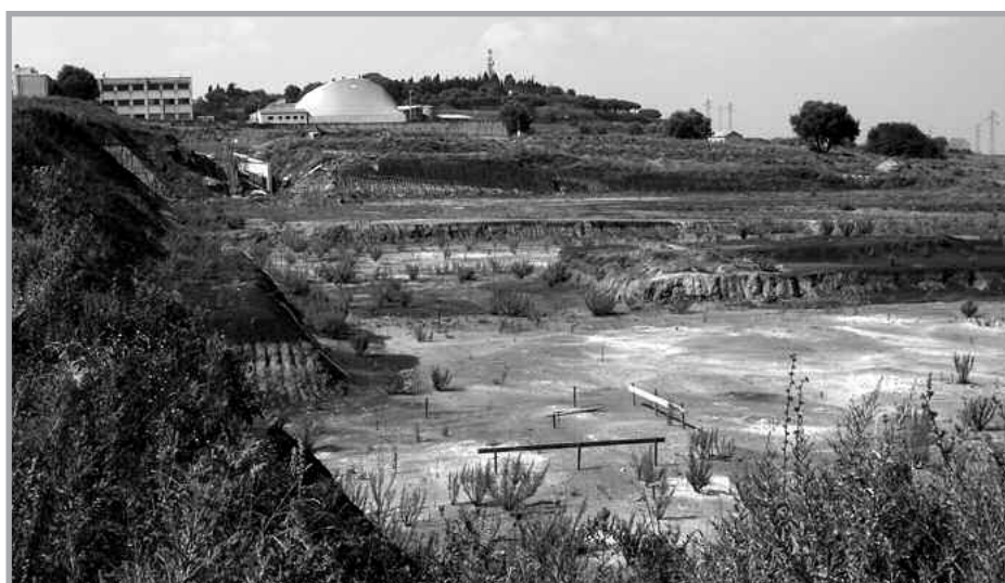
IL SOGNO INFRANTO Sopra il progetto del nuovo ospedale. Sotto il cantiere morto
